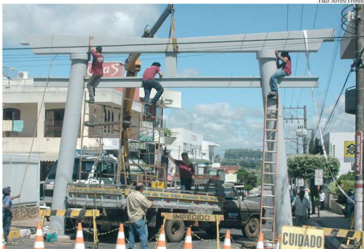
PRIMEIRO PORTAL – A Prefeitura e a Marcofer, concluíram ontem a instalação do primeiro de quatro portais japoneses (torii) que irão decorar as Ruas Presidente Vargas (foto) e Adhemar de Barros, no centro de Bastos. Tubulação de água da Sabesp encontrada pela Prefeitura exigiu mudança na estrutura da fundação do primeiro torii. Esse problema e a alta incidência de chuvas causaram atraso no cronograma de obras. A previsão da Secretaria de Planejamento agora é que os quatro toriis sejam entregues já com acabamento até meados de março e não mais em 28 de fevereiro. O investimento nos portais é de R$ 34,2 mil.
