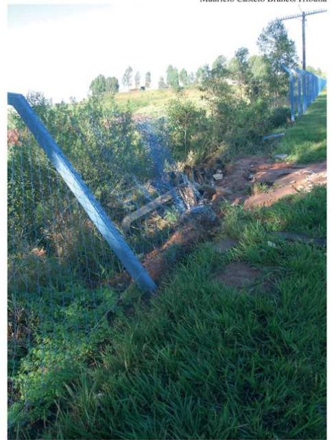
Alameda derrubada pelo Fusca, que caiu de barranco de 2m
